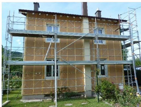
Isolation par l'extérieur d'une maison individuelle
